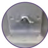
Fissaggio con galletto e bullone
