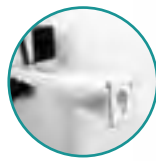
Fissaggio della struttura al muro
